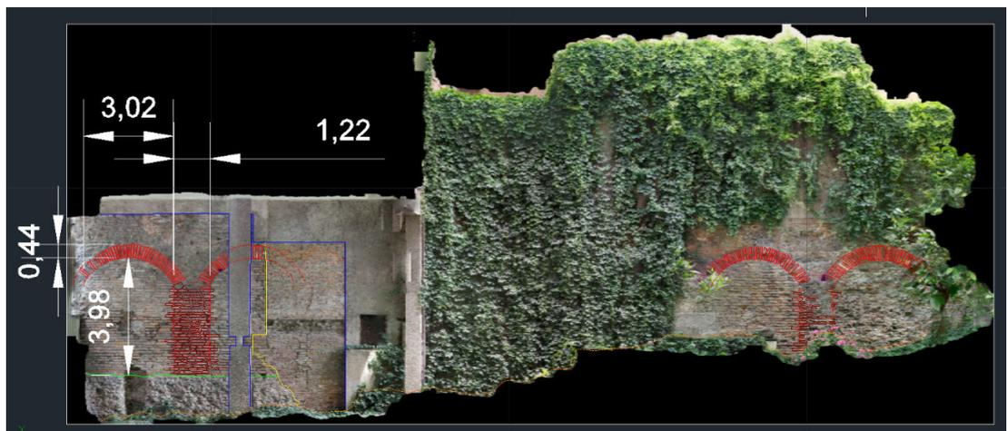
Figura 6. Dettaglio del ridisegno delle tracce di archi e pilastri del muro del circo in Via Vigna 1
